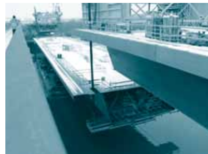
Baumaßnahme Schiersteiner Brücke
